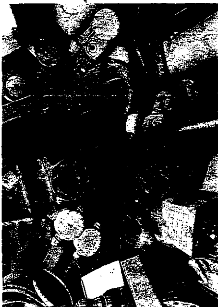
11.เครื่องจ่ายเคมี (สารส้ม) ขนาดสูบจ่ายได้ 1060 ลิตร/ชม. พร้อมด้วยมอเตอร์ ขับเคลื่อน(ปั๊มฟวง 2ตัวต่อ 1 ชุด ขนาดสูบ จ่าย 530 ลิตร/ตัว)และ SERVO-MOTOR พร้อมอุปกรณ์ เลขที่พัสดุ 209-43-001-006
