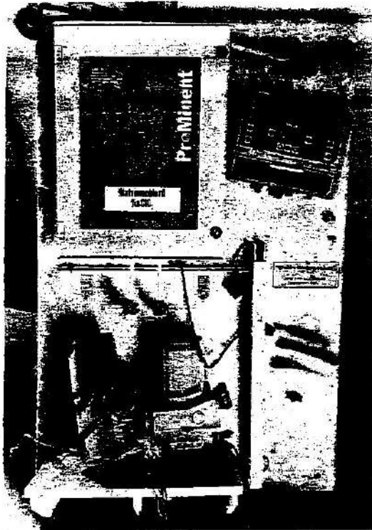
5.เครื่องผลิตจ่ายคลอรีนไดออกไซด์ ขนาด 520 กรัม/ชม. พร้อมด้วยระบบควบคุมและคอนโทรลส์อัตโนมัติ เลขที่พัสดุ 296-38-001
