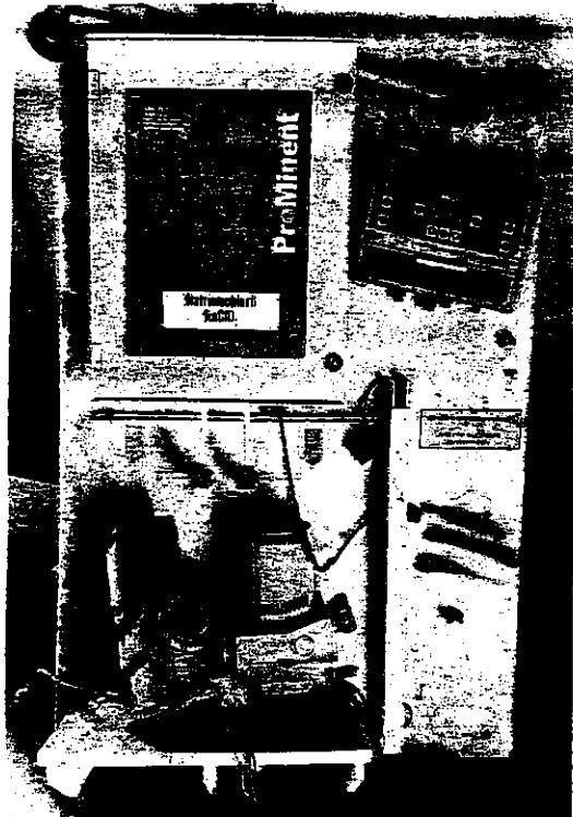
5.เครื่องผลิตจ่ายคลอรีนไดออกไซด์ ขนาด 520 กรัม/ชม. พร้อมด้วยระบบควบคุมและคอนโทรลอัตโนมัติ เลขที่พัสดุ 296-38-001
